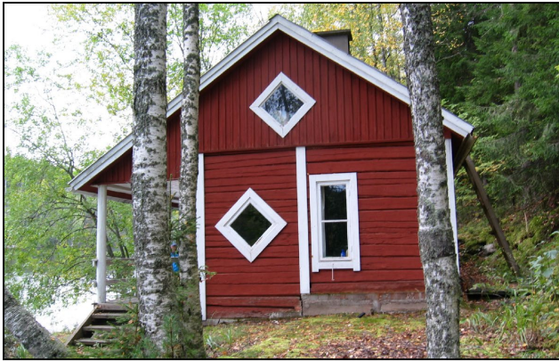
Pohjoisrinteellä sijaitsevan saunamökin hirsinen saunaosa lienee rakennettu 1950-luvulla. Myöhemmin rakennusta on laajennettu lautarakenteisella huonetilalla. Rakennus on käyttökielossa homeongelman vuoksi.
