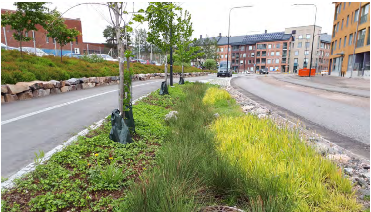
Kuva 12: Toteutunut biosuodatusaihe kadun varrella Helsingin Kuninkaantammassa. Kuva: Ramboll.
