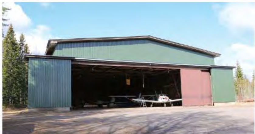
Kuva 3-13. Rakennusinventoinnissa asemakaavalla suojeltavaksi esitetty lentokonehalli.
