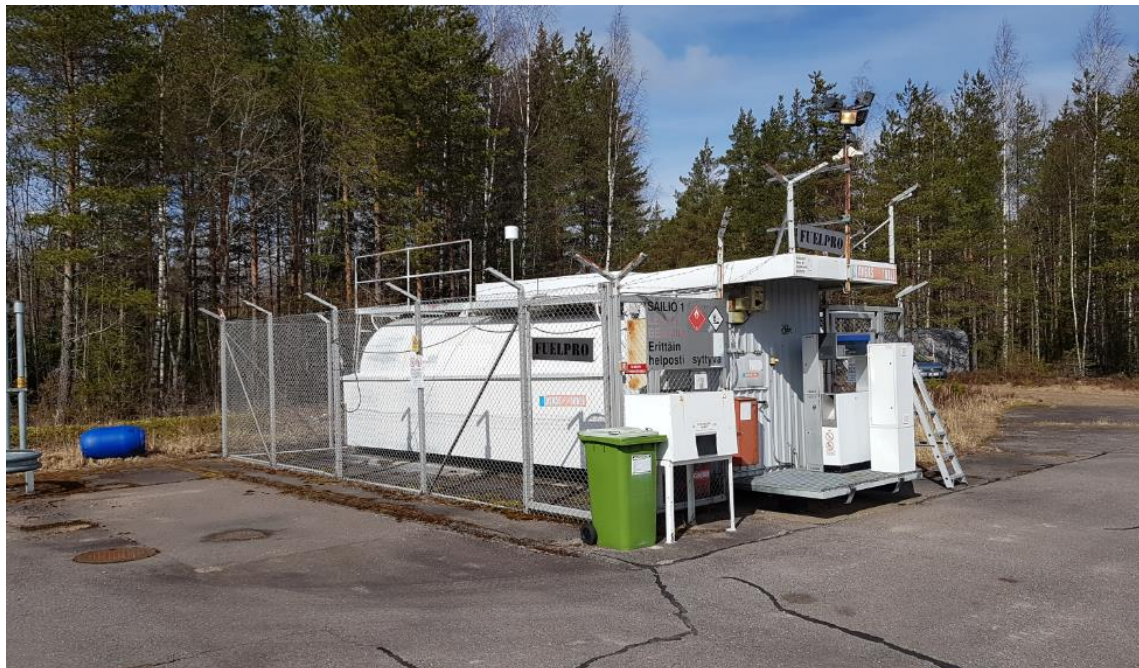
Kuva 4, lentokoneiden polttoaineenjakuasema
