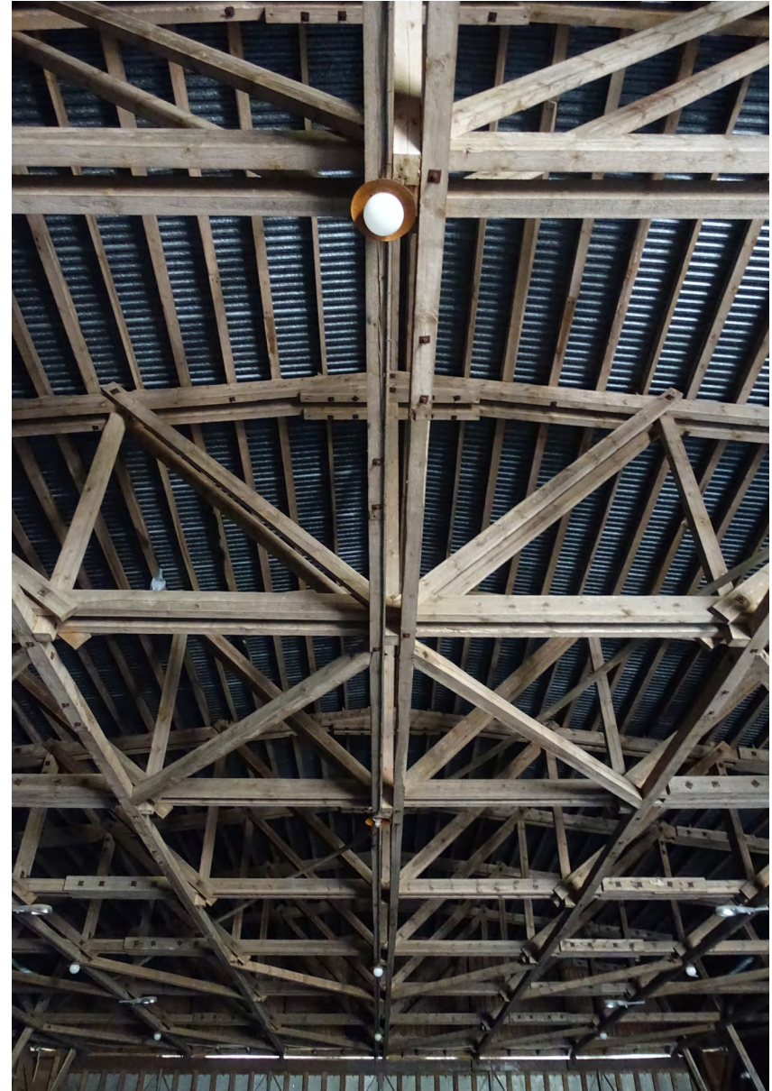
Lentokonehallin liukuovet, seinärimoitus ja kattorakenne alkuperäisessä asussaan.
