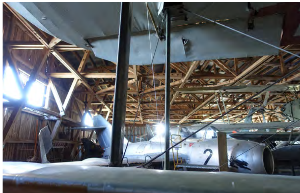
Museohallin sisätilat kattotuoleineen ja tuuliristikoineen ovat säilyneet hyvin alkuperäisessä asussaan.
