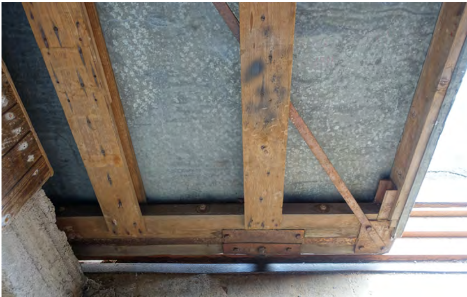
Lentokonehallin liukuovet, seinärimoitus ja kattorakenne alkuperäisessä asussaan.
