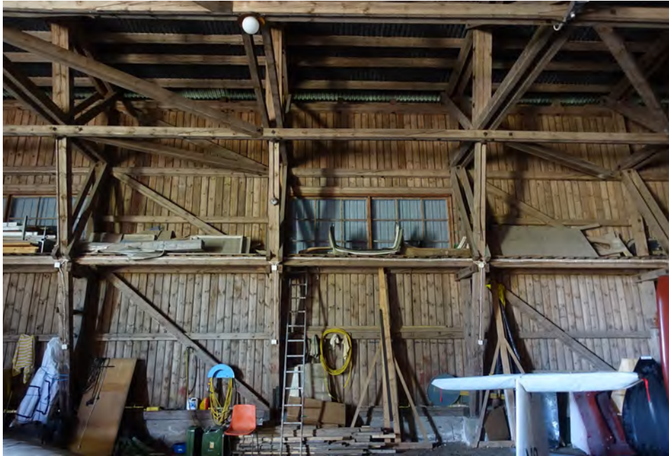
Lentokonehallin sisätilat kattotuoleineen ja tuuliristikoineen ovat säilyneet hyvin alkuperäisessä asussaan. Ikkunat on peitetty jälkikäteen aaltopellillä.
