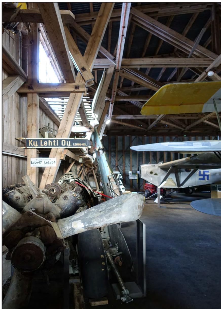
Museohallin sisätilat kattotuoleineen ja tuuliristikoineen ovat säilyneet hyvin alkuperäisessä asussaan.
