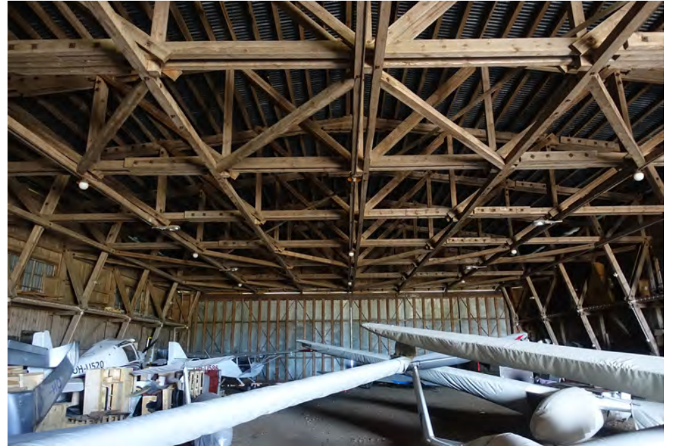
Lentokonehallin sisätilat kattotuoleineen ja tuuliristikoineen ovat säilyneet hyvin alkuperäisessä asussaan. Ikkunat on peitetty jälkikäteen aaltopellillä.
