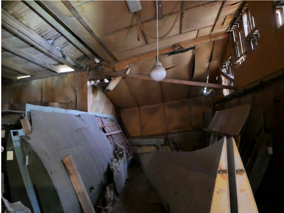
Korsuhallin katto- ja seinärakenteet äilyneet alkuperäisessä asussa. Kuvat: Päivi Siikaniemi.
