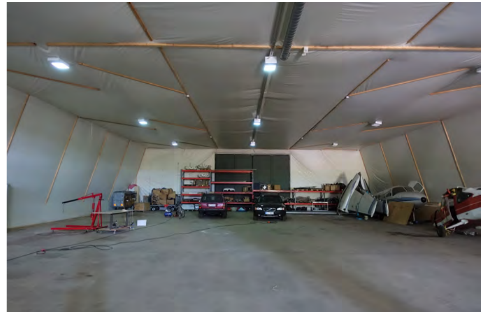
Varastohallin sisätilat ovat muuttuneet vuosien varrellatäysin alkuperäisestä asustaan.
