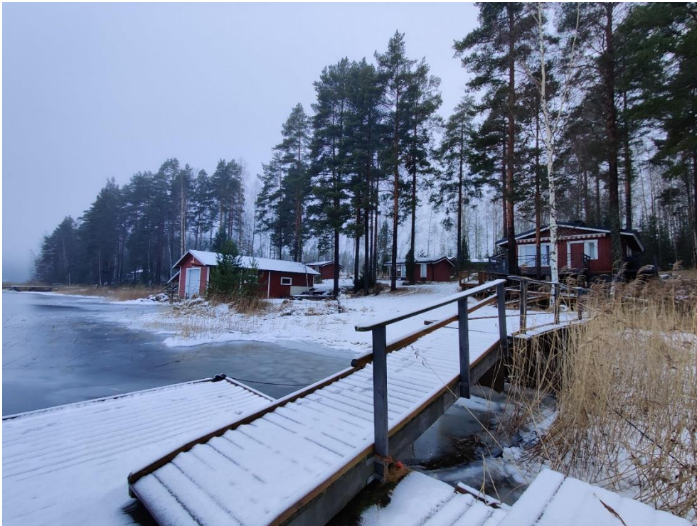
Kuva 2-6 Rakennuskantaa idästä päin kuvattuna (B)
