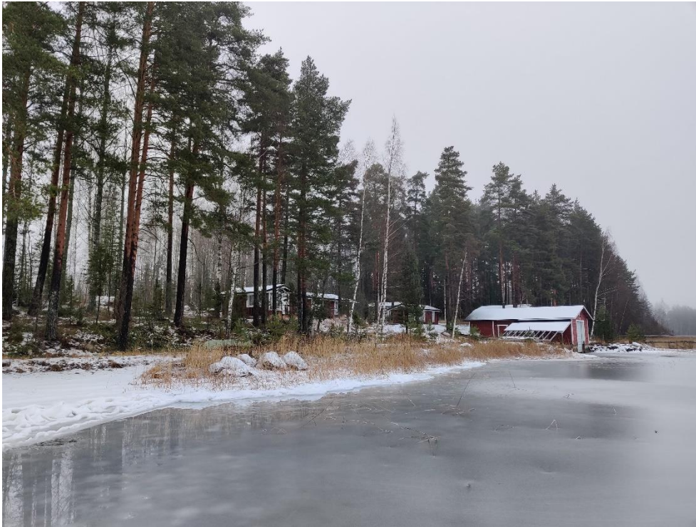
Kuva 2-7 Rakennuskantaa etelästä päin kuvattuna (C)
