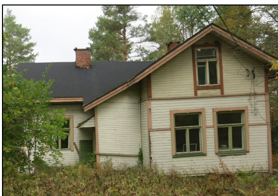
Rakennuksen perustukset ovat pahasti painuneet. Rannan puoleinen kuisti on purettu.
