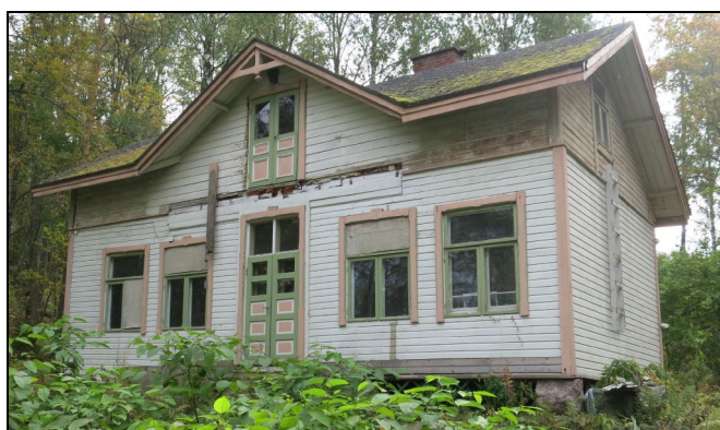
Rakennuksen perustukset ovat pahasti painuneet. Rannan puoleinen kuisti on purettu.
