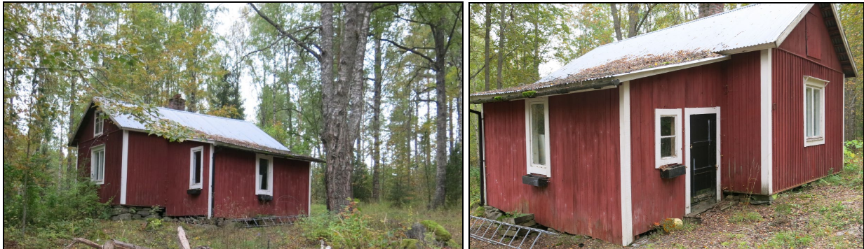
Pitkää asumattomana ollut asuinrakennus lienee rakennettu 1910-luvulla sen jälkeen, kun Hietamäen tila oli erotettu Mikkolan emätilasta.
