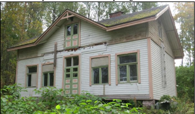
Rakennuksen perustukset ovat pahasti painuneet. Rannan puoleinen kuisti on purettu. Rannassa on uudehko sauna.
