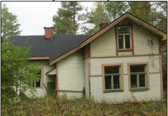
Rakennuksen perustukset ovat pahasti painuneet. Rannan puoleinen kuisti on purettu. Rannassa on uudehko sauna.
