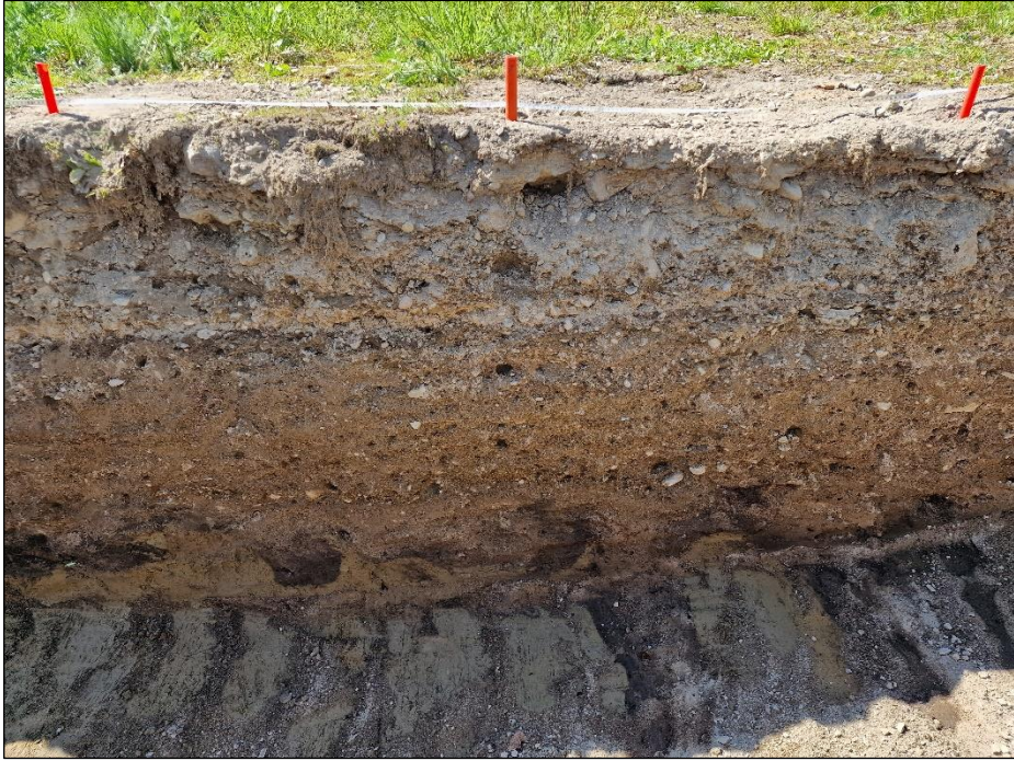
Paaluväli 6 (oikealla) – 8 m. Tierakenteen kerroksellisuutta
