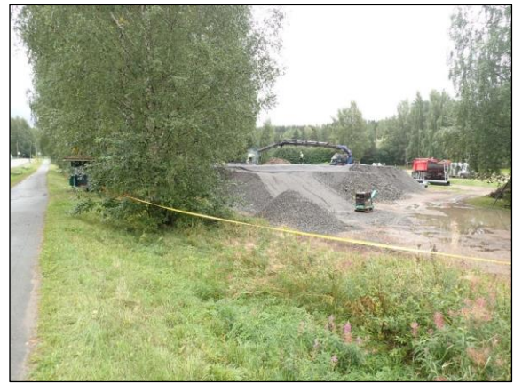
Kuva 4. Urheilukentän pohjoispuolelle oli rakenteilla liikuntarata.
