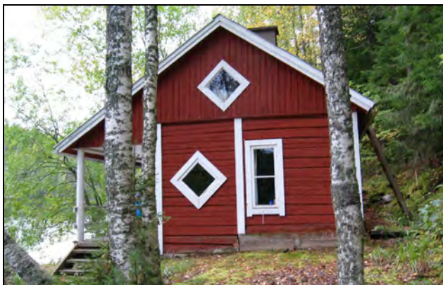
Huonopohjan pohjoisrinteellä sijaitsevan saunamökin hirsinen saunaosa lienee rakennettu 1950-luvulla. Myöhemmin rakennusta on laajennettu lautarakenteisella huonetilalla. Maanomistaja (Vantaan seurakuntayhtymä) on asettanut rakennuksen käyttökieltoon homeongelman vuoksi. Homeongelma on seurausta epäasiallisesta perustamistavasta. Voimakas homeen haju tuntuu myös rakennuksen ulkopuolelle.
