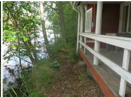
Huonopohjan pohjoisrinteellä sijaitsevan saunamökin hirsinen saunaosa lienee rakennettu 1950-luvulla. Myöhemmin rakennusta on laajennettu lautarakenteisella huonetilalla. Maanomistaja (Vantaan seurakuntayhtymä) on asettanut rakennuksen käyttökieltoon homeongelman vuoksi. Homeongelma on seurausta epäasiallisesta perustamistavasta. Voimakas homeen haju tuntuu myös rakennuksen ulkopuolelle.
