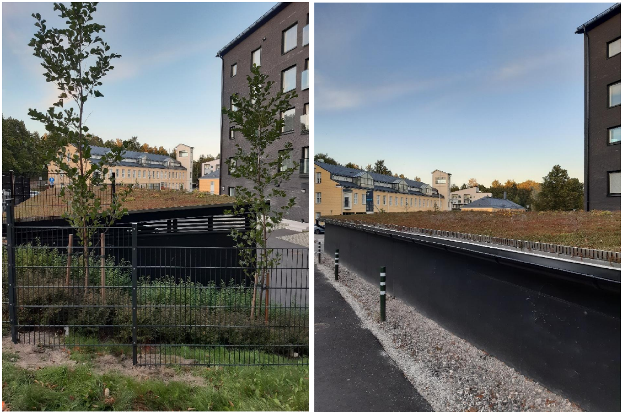
Kuva 14: Esimerkkikuva Lahdessa sijaitsevan kerrostalon parkkikatoksesta, jossa on käytetty viherkattoja.
