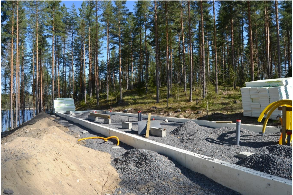
Kuva 2-12 Suunnittelualueelle on rakenteilla pitkä lamellimainen vapaa-ajan asuinrakennus (12.5.2023).
