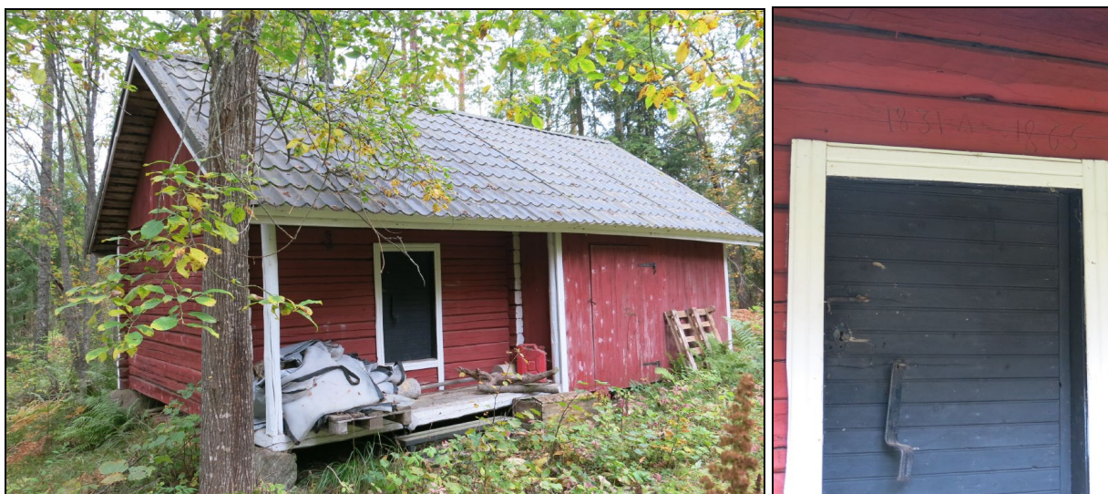
Aitassa on vuosilukumerkintä 1831-1865. Rakennus lienee siirretty muualta.
