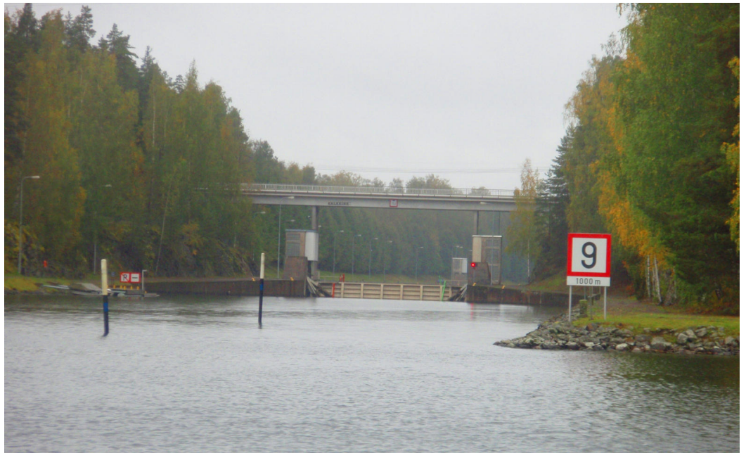
Kuva: Kalkkisten kanavan sulku.
