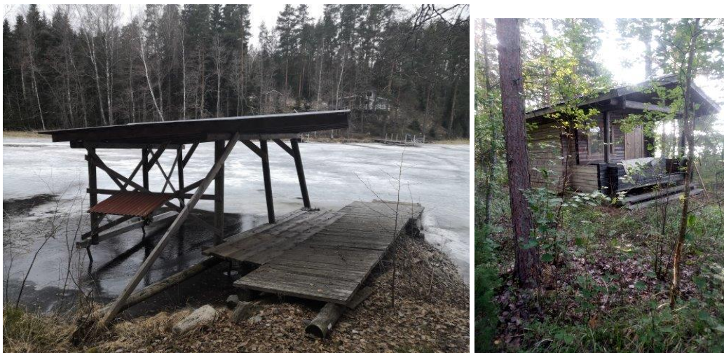
Venekatos ja laituri Lahtelaistenpohjukan kohdalla sekä Savonsaaren lomarakennus.
