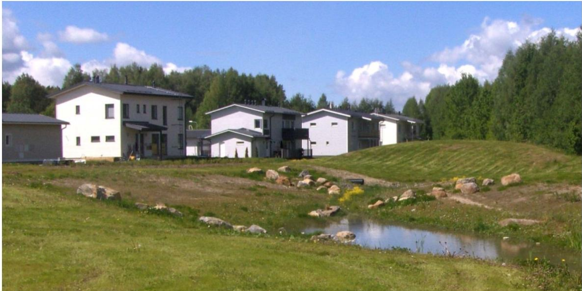
Kuva 11: Rambollin suunnittelema hulevesien luonnonmukainen viivytyalue Vaarinmaalla, Kangasalla vuosi rakentamisen jälkeen. Käsittelyalueella yhdistyy pysyvän veden alue sekä sitä ympäröivä tulvaniityn alue.
