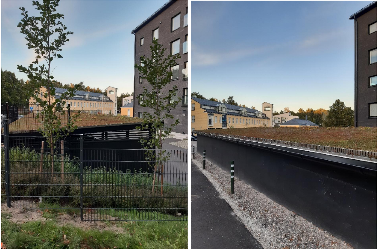
Kuva 14: Esimerkkikuva Lahdessa sijaitsevan kerrostalon parkkikatoksesta, jossa on käytetty viherkattoa.
