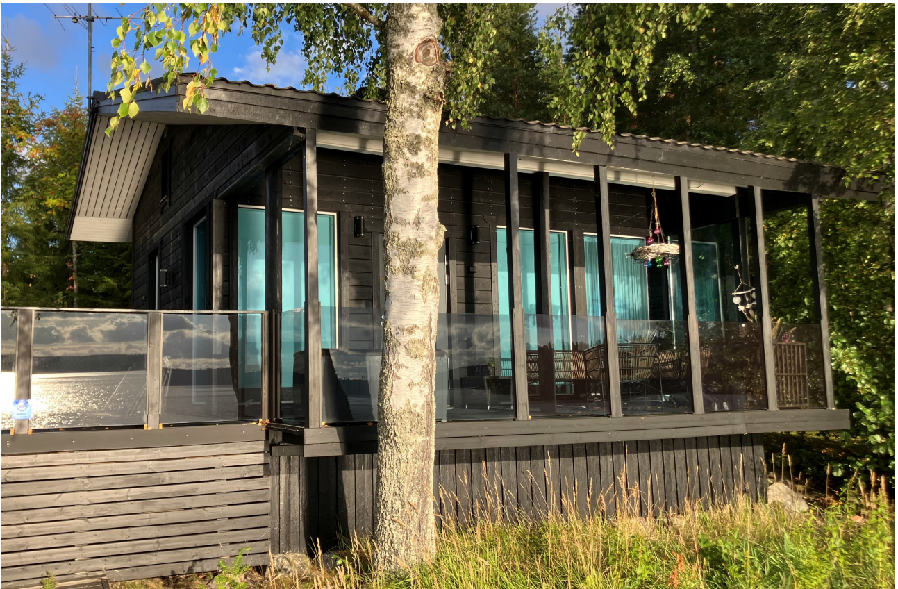
Kuva 8. Kiinteistön Suviniemi länsiosassa oleva vanha vierasmajarakennus, jota on kunnostettu ja remontoitu.
