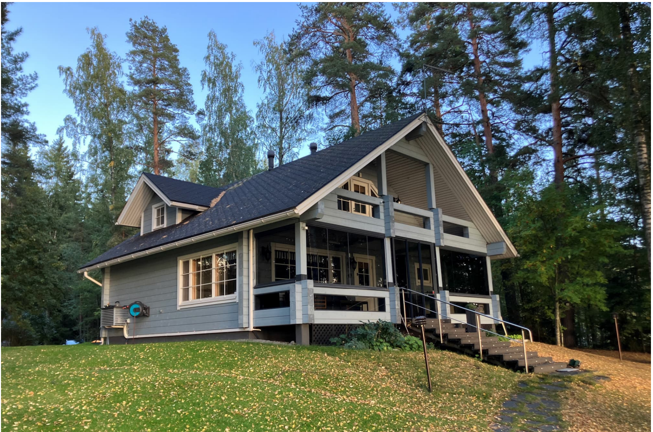
Kuva 6. Kiinteistöllä Postiranta oleva hirsirakenteinen loma-asuinrakennus.
