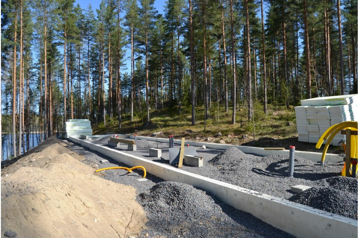
Kuva 2-12 Suunnittelualueelle on rakenteilla pitkä lamellimainen vapaa-ajan asuinrakennus (12.5.2023).
