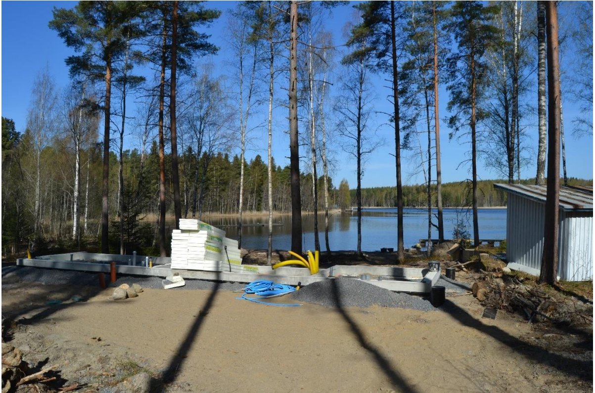
Kuva 2-13 Suunnittelualueen rannalle on rakenteilla saunarakennus (12.5.2023).
