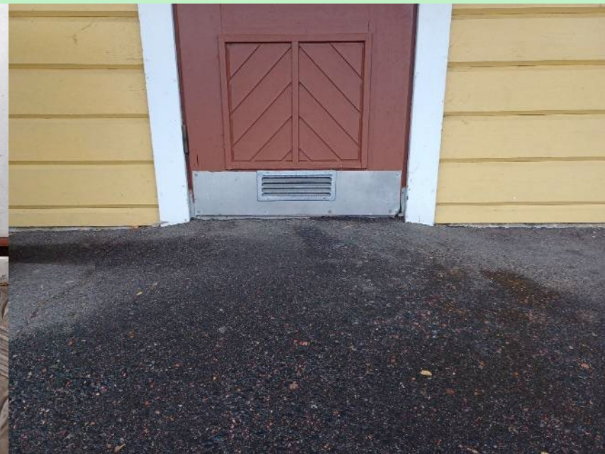
Kuva 3. WC-tilan ovella asfaltti on lähes kynnyksen tasalla.
