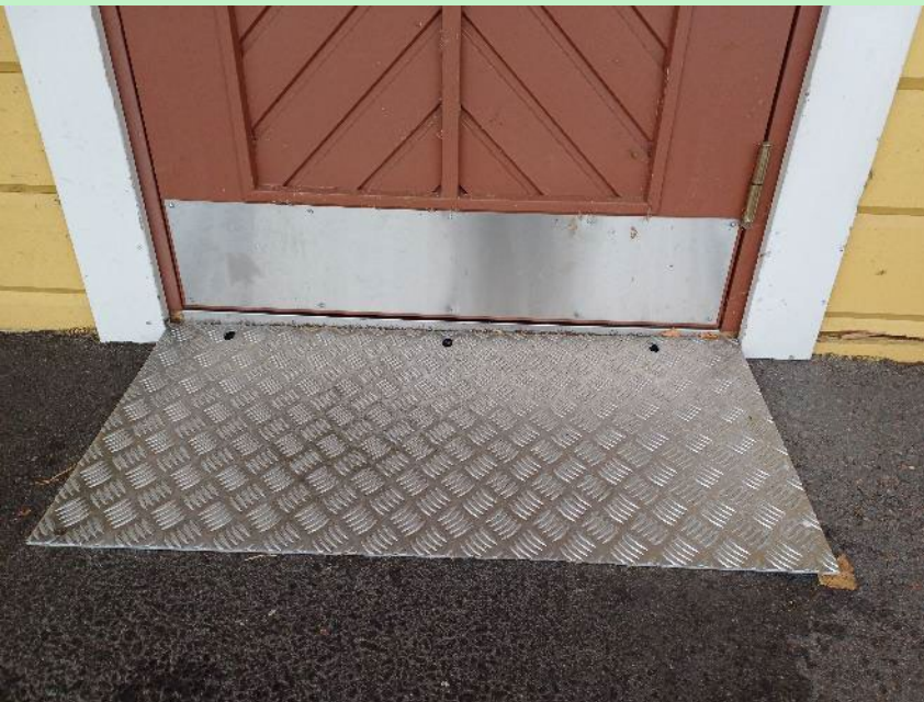
Kuva 1. & 2. Majakkapaviljongin sisäänkäynnin luiska on vinossa ja siitä puuttuu suojareuna. Luiskasta huolimatta ovella on kynnyks.
