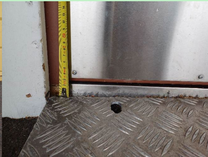
Kuva 1. & 2. Majakkapaviljongin sisäänkäynnin luiska on vinossa ja siitä puuttuu suojareuna. Luiskasta huolimatta ovella on kynnyks.
