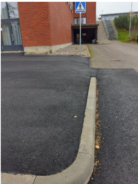
Kuva x. Pohjoispuolinen luiska korotetulle kulkuväylälle
