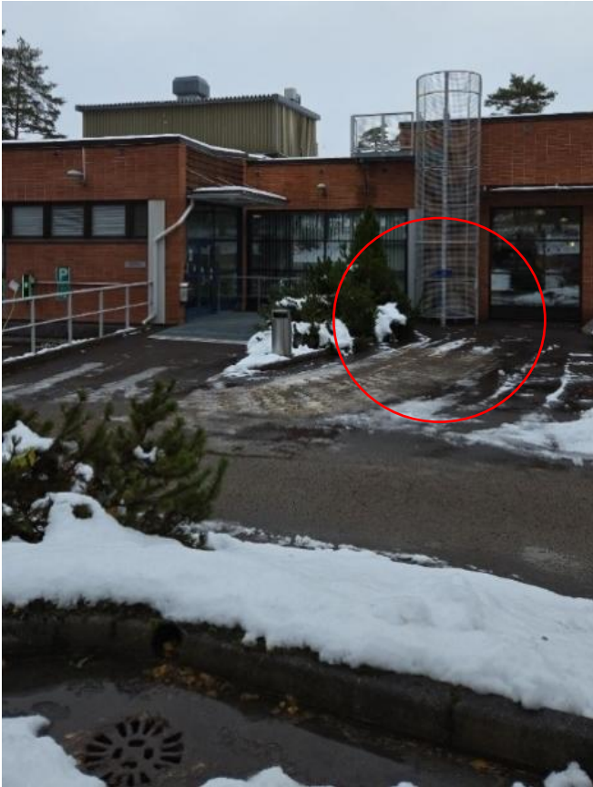
Teknisen viraston pääsisäänkäynti, invapaikka ympyröity.
