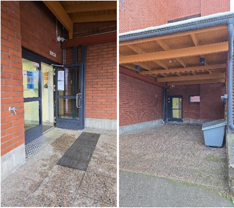
Pääsisäänkäynti ja läntinen sisäänkäynti
