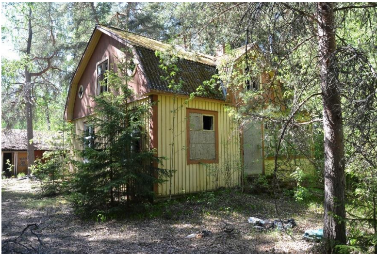
Kuva 3-17. Kiinteistöllä 5:9 Puotitien varressa metsittyneellä tontilla sijaitsee vanha purkukuntoinen rakennus.
