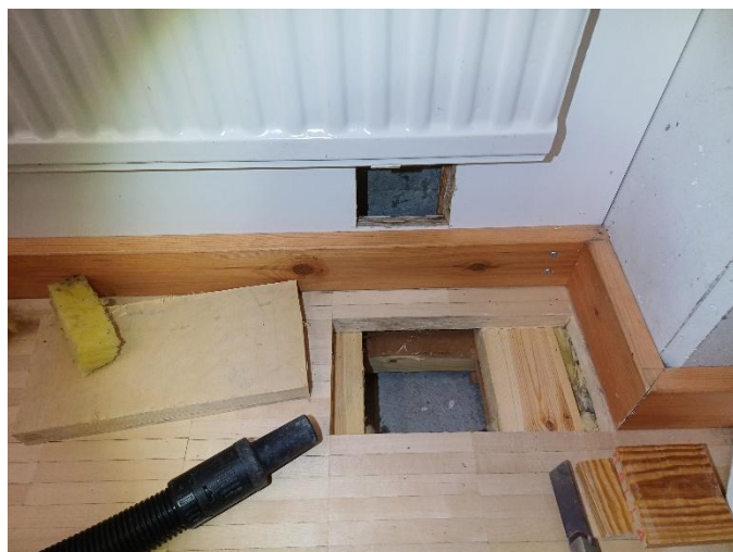
Kuva 35 Liikuntasalin lattiaan ja maanpaineseinään rakenneavaukset
