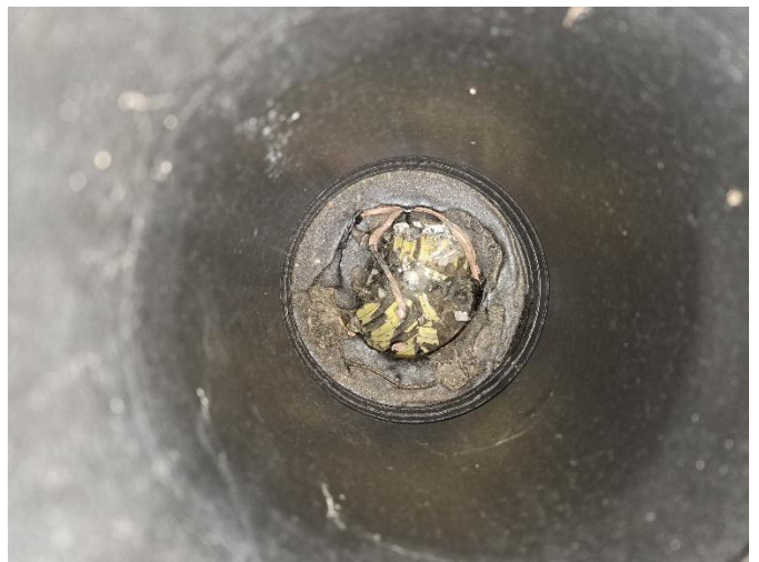
Kuva 14 Tuuletusputken kohdalla ilmayhteys yläpohjatilaan
