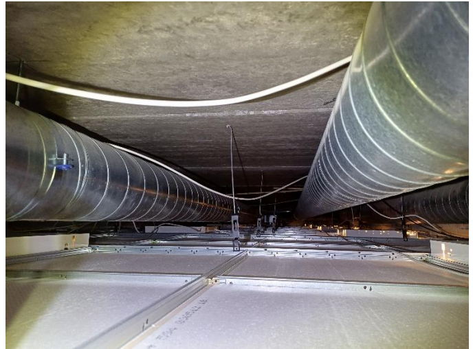
Kuva 26 Yleiskuva alaslaskun päältä
