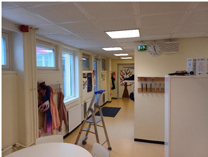
Kuva 23 Alaslaskettujen kattojen tarkistus käytäviltä
