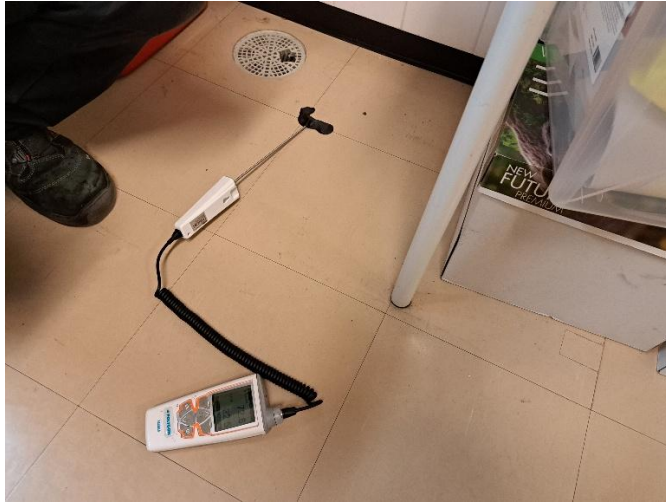
Kuva 43 Tilan 013 lattian kosteusmittaus lattiakaivon vierestä
