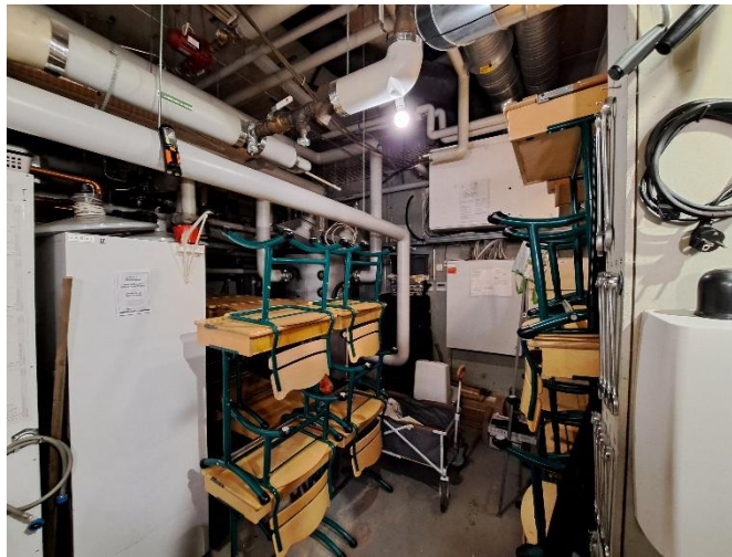
Kuva 31 Lämmönjakuhuoneen vierisessä IV-konehuoneesta lähtee muihin tiloihin tekniikkaläpivientejä
