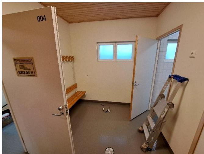
Kuva 41 Pukuhuoneen lattiapinnoitteen kosteusmittaus
