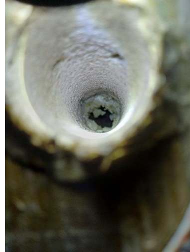
Kuva 44 Tilan xx rakennetarkistus poraamalla
