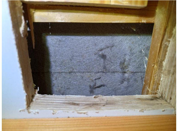
Kuva 38 Maanpaineseinän rakenneavaus
