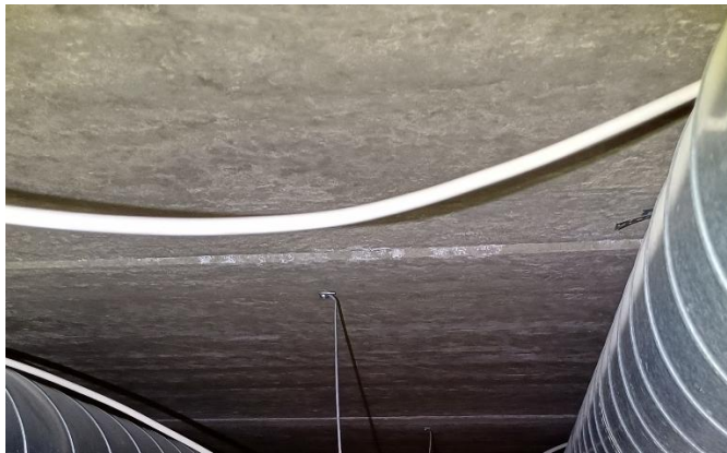
Kuva 45 Yläpohjassa todettiin olevan ontelolaatasto
