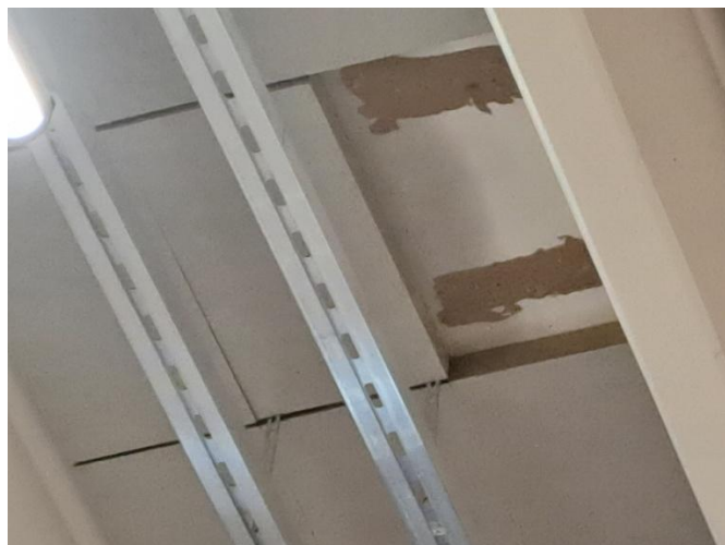
Kuva 18 Liikuntasalin katossa reunoiltaan paljaat äänieristelevyt
