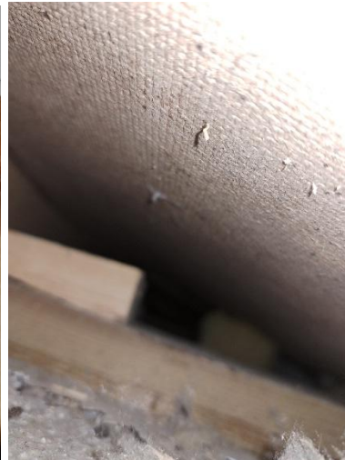
Kuva 40 Kovalevyn alapinnassa mustaa pilkkua (mikrobikasvua)
