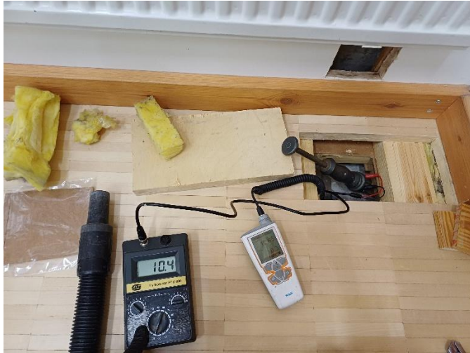
Kuva 37 Kosteusmittauksissa ei havaittu kohonneita kosteusarvoja
