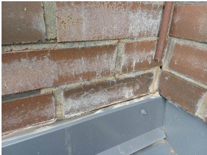
Kuva 13 Piipun pellitysten massauksessa rako
