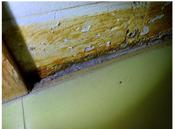
Kuva 22 Luokkien ja käytävän väliseinä lähtee pohjalaatan päältä
