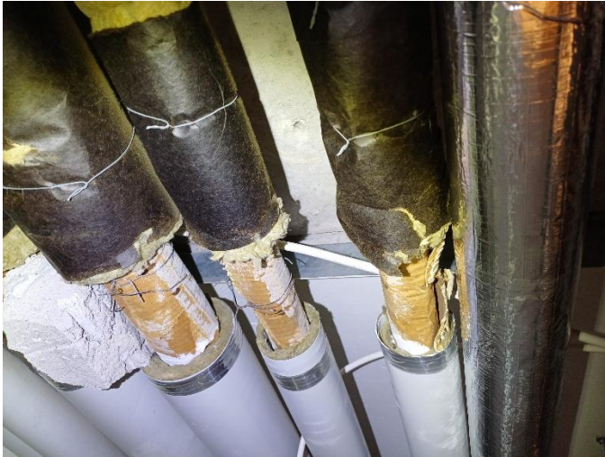
Kuva 25 Vanhoja putkia on eristetty uudelleen
