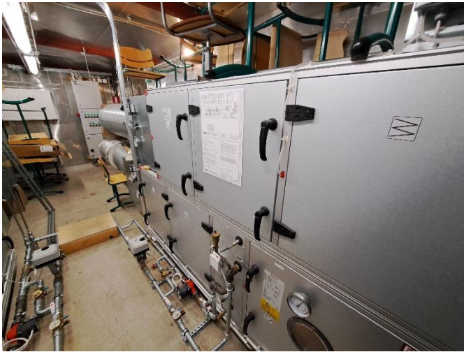
Kuva 29 Ilmanvaihtokonehuoneet ja koneet ovat hyväkuntoisia
