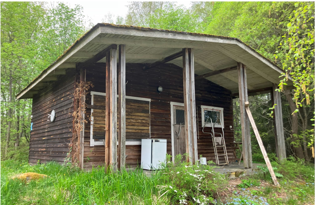
Kuva 7. Rantasaunarakennus rannasta päin kuvattuna.
