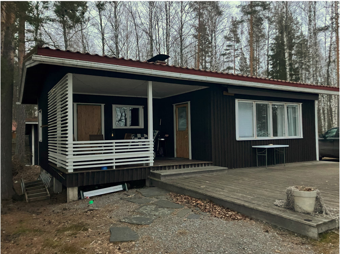
Kuva 6. Loma-asuinrakennus rannasta päin kuvattuna. Rakennuksen takana näkyy varastorakennuksen kulma.
