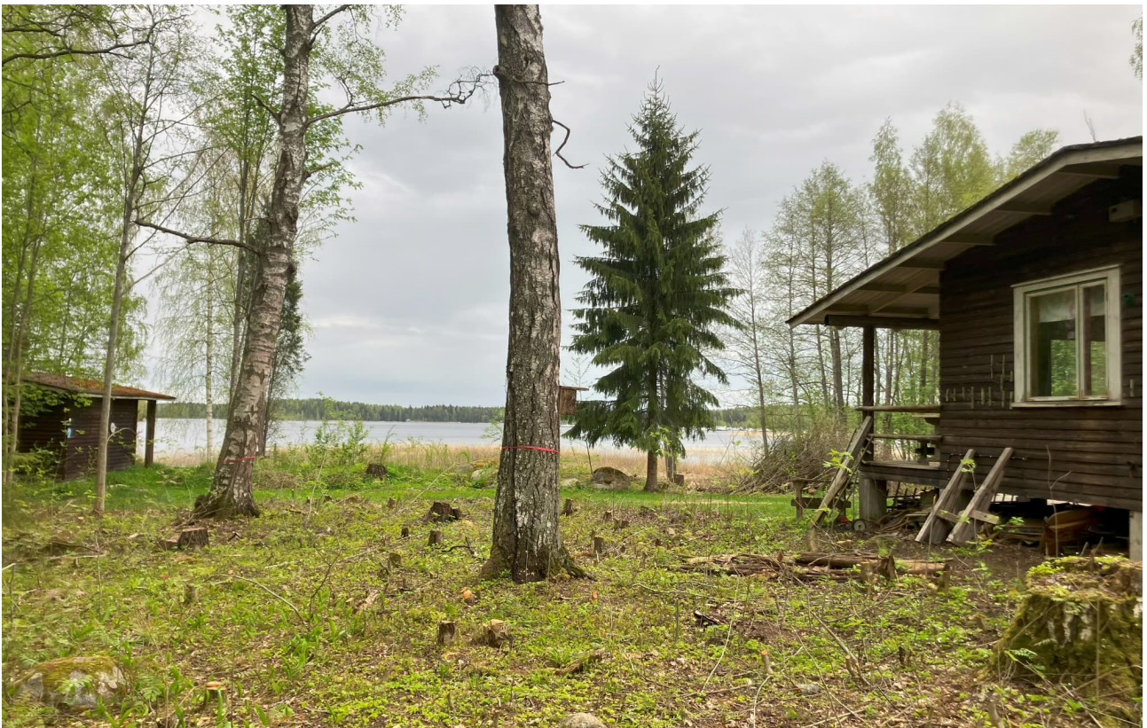
Näkymä purettujen loma-asuinrakennuksen ja rantasaunan välistä järvelle.
