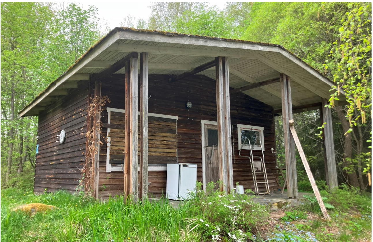
Purettu rantasaunarakennus rannasta päin kuvattuna.
