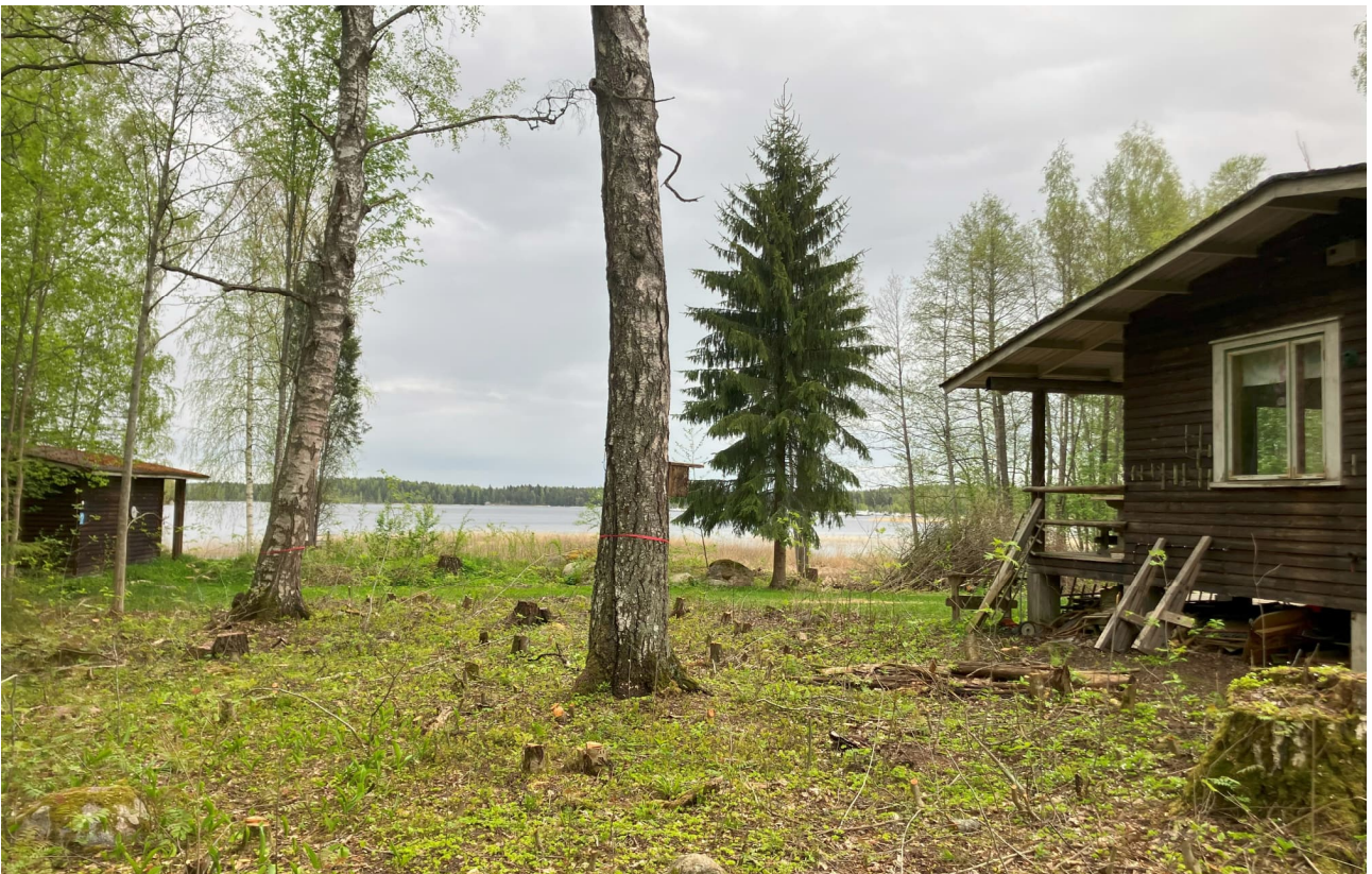
Näkymä purettujen loma-asuinrakennuksen ja rantasaunan välistä järvelle.
