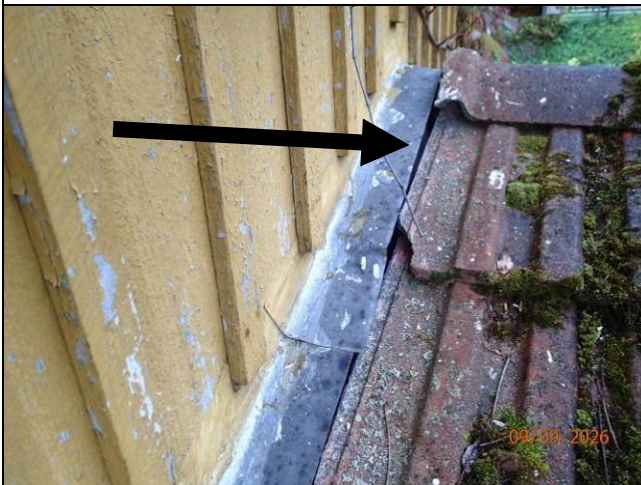
Kuva 27 Rako rintapellin ja tiilikatteen välissä sisäänkäyntikuistilla.
