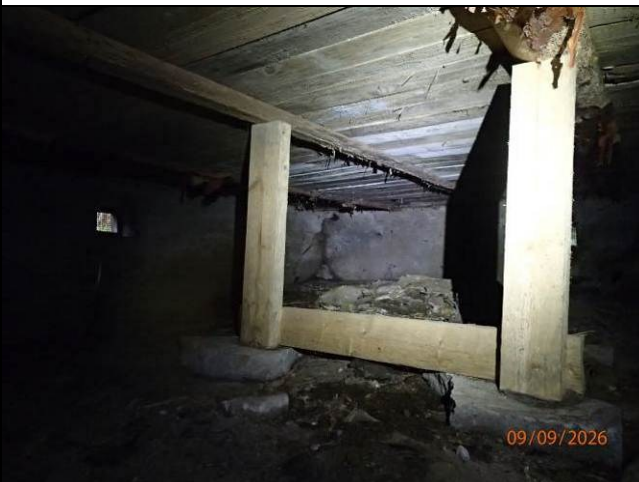
Kuva 3 Alapohjarakenteen tukilankut ryömintätilassa. Alapohjarakenteita on uusittu.
