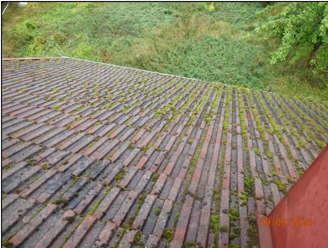
Kuva 23 Pohjoislappeella on sammalta.
