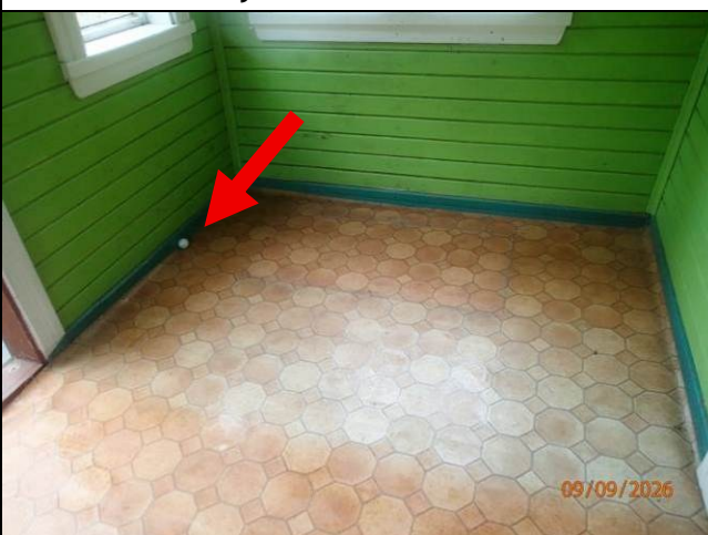
Kuva 15 Sisäänkäyntikuistin lattia viettää kuistin kallistumisen takia ulospäin (huom. pallo).
