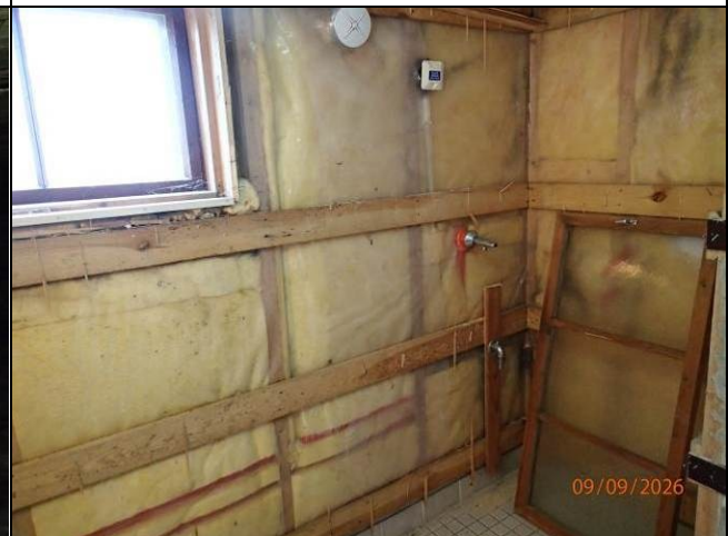
Kuva 4 Maanvastaisia lämmöneristettyjä ulkoseinärakenteita (pesuhuone).
