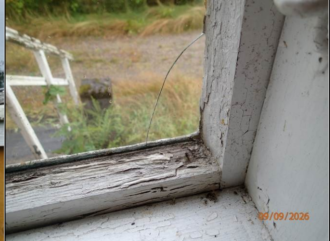
Kuva 18 Hajonnut ikkunalasi.
