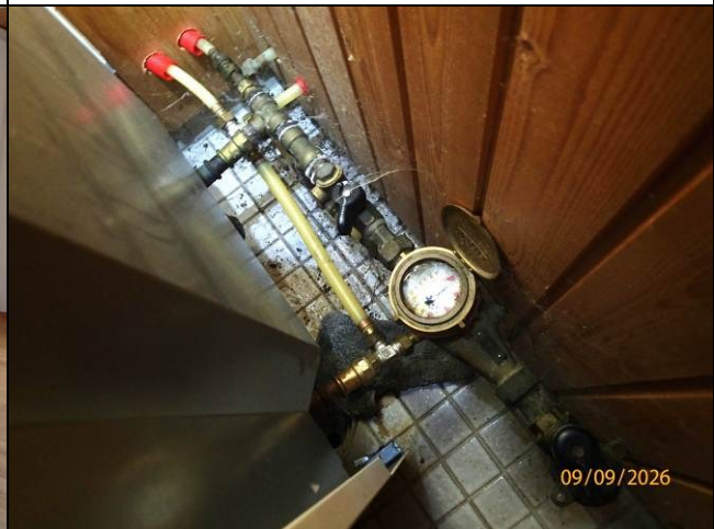
Kuva 48 Vesimittari.
